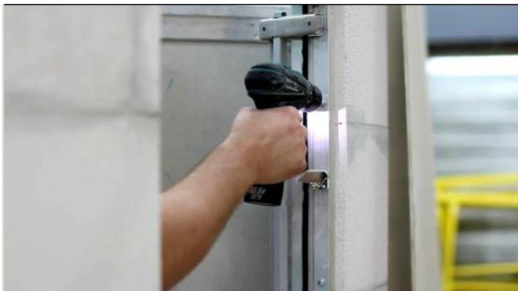
9. Оцениваем положение вертикальной плоскости рамы по **уровню**. При необходимости следует подтянуть или ослабить саморезы в вертикальной плоскости для изменения угла наклона рамы.
