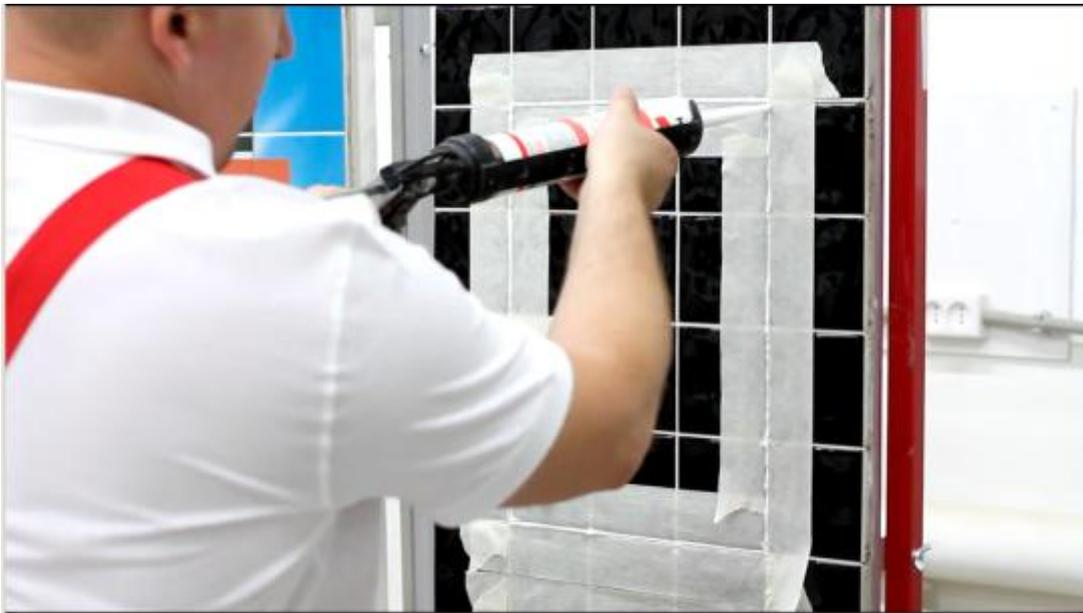
Уплотняем герметик, можно просто провести пальцем по периметру шва.
