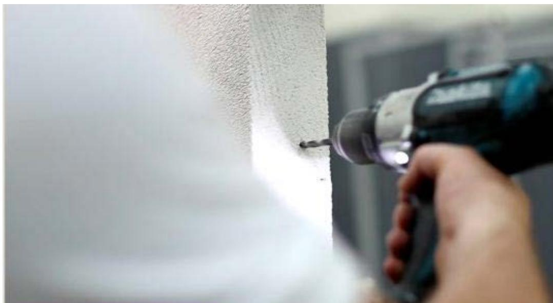
6. Забиваем дюбеля в отверстия, просверленные в ребрах проема.
