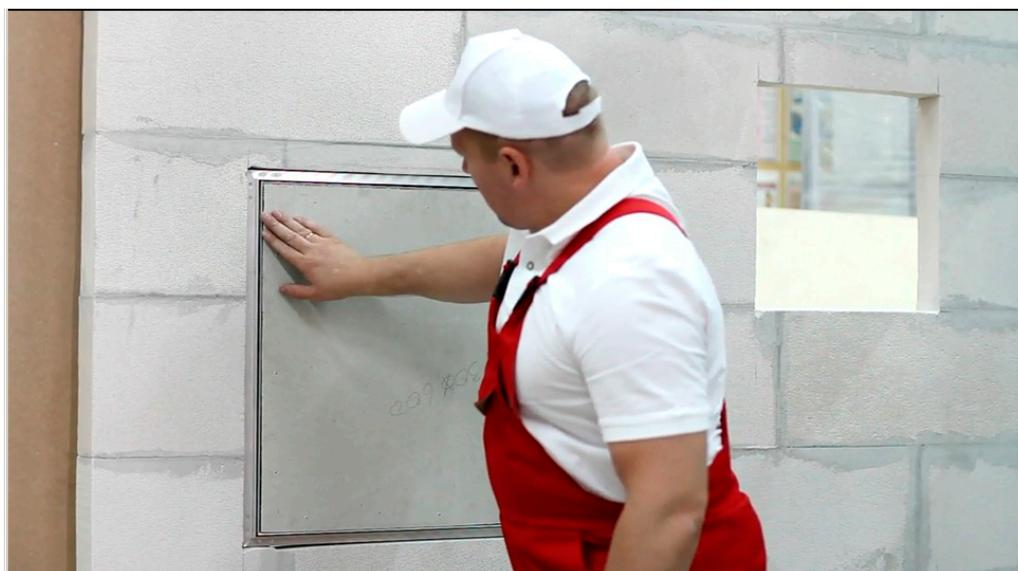
11. Если не удастся достичь регулировки за счет саморезов, следует провести финишную доводку кромок проема. Как правило, достаточно устранить небольшие неровности кромок или скорректировать геометрию углов проема.
