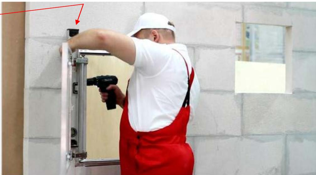
10. Оцениваем общее положение рамы, достигаем отсутствия перекосов затягивая/ослабляя саморезы на каждой из плоскостей рамы.
