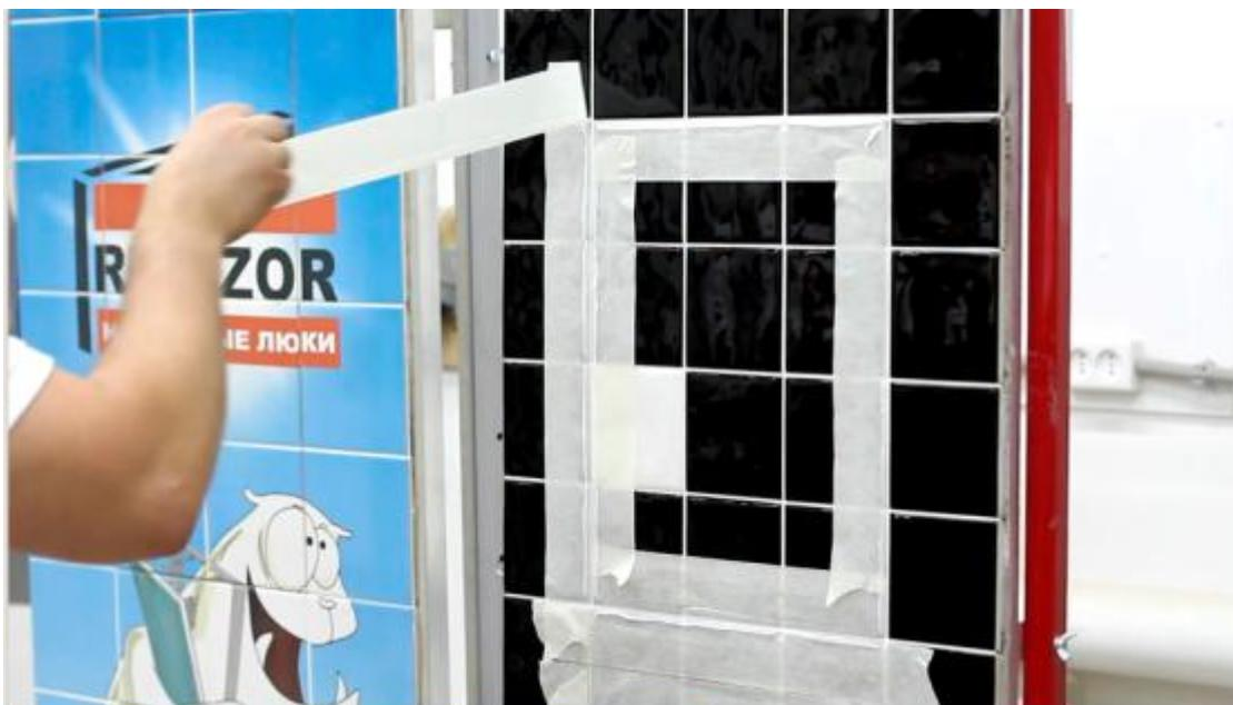
Прорезать проем дверцы острым ножом. Нож следует держать под углом 30-40 градусов, с наклоном лезвия в сторону внутренней части двери люка. Прорезать следует так, чтобы отделяемая часть герметика оставалась на ребре плитки люка, а не на ребре плитки закрывающей раму.
