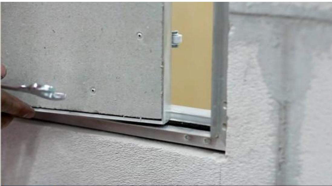
При правильной установке и регулировке зазоры между рамой и дверью люка одинаковые по всем сторонам и составляют 3-4 мм.
