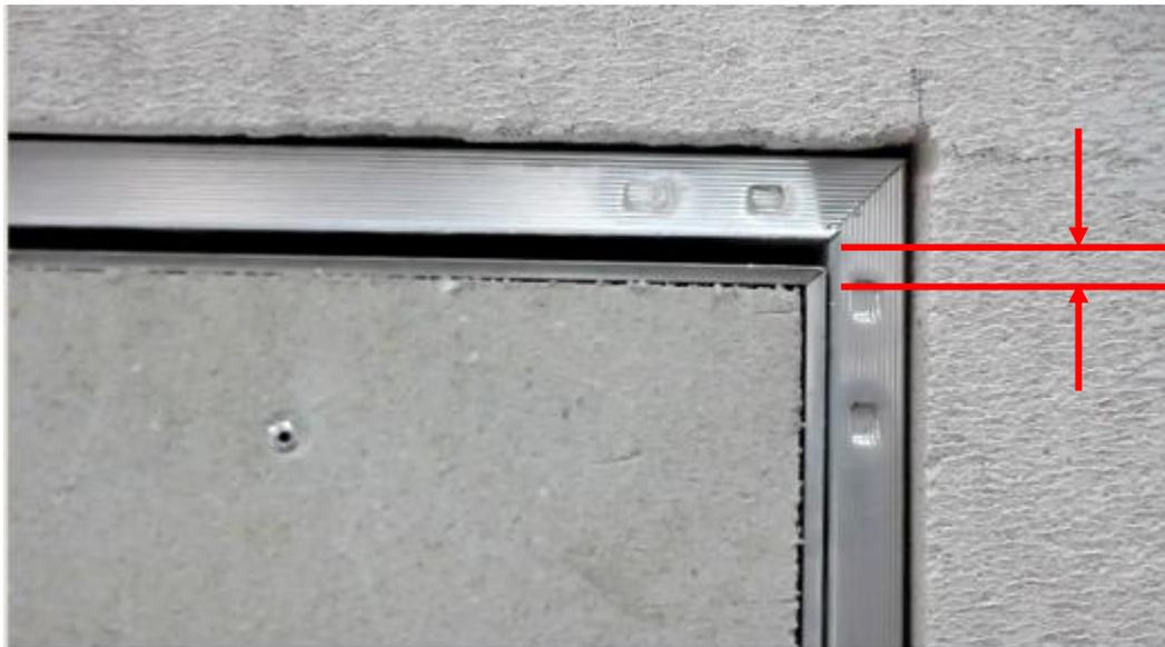
Не правильно (не отрегулирован угол наклона двери, дверь будет цепляться за раму):
