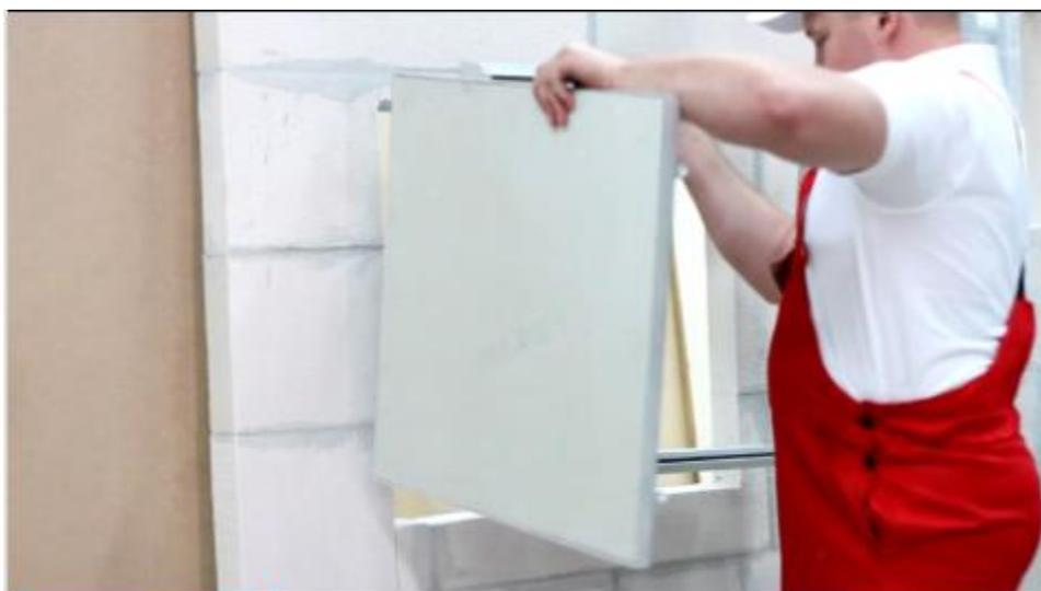
Очень важно разместить люк в проеме таким образом, чтобы дверь люка выступала на 2-3 мм. вперёд по отношению к лицевой части стены. Такая особенность установки обеспечивает возможность работы замка люка, которому для срабатывания достаточно 3 мм хода.
